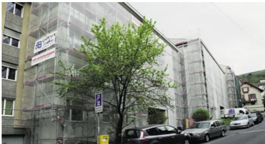
Les travaux d'assainissement de trois immeubles d'habitations ont débuté à la rue de Gibraltar.
