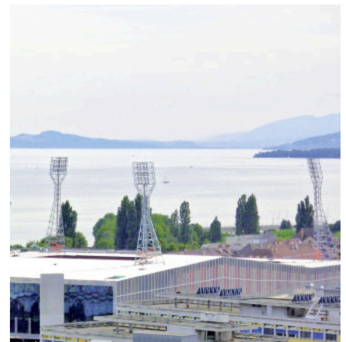
Toiture solaire photovoltaïque
