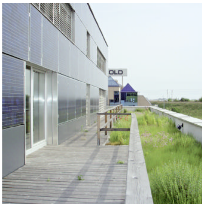
Façade solaire photovoltaïque
