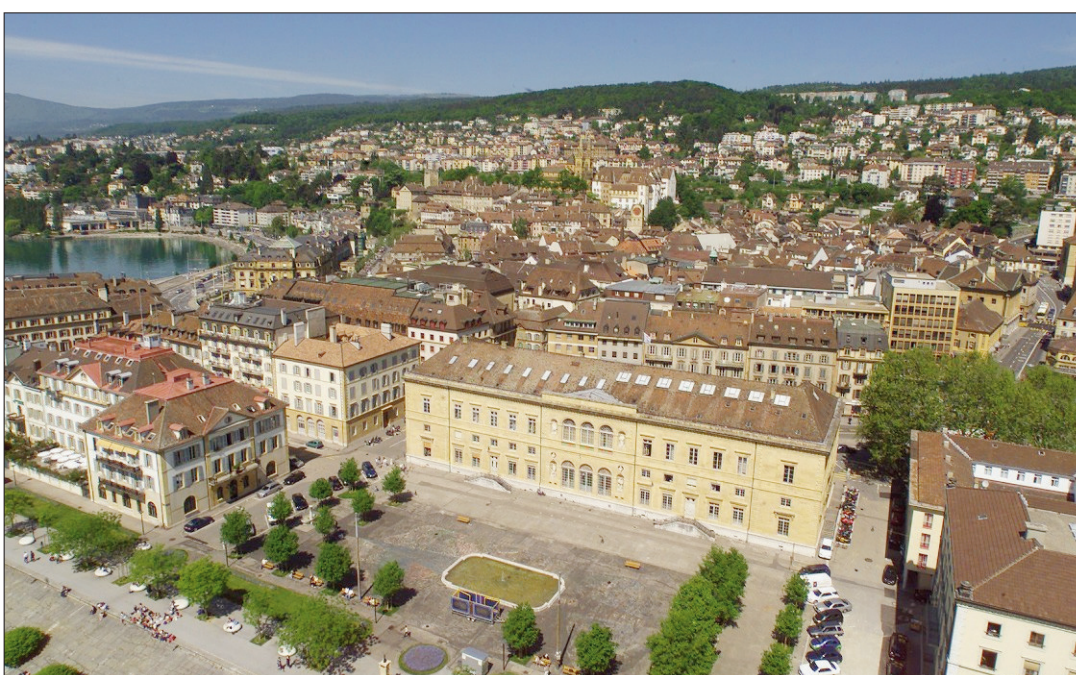
VUE AÉRIENNE CLASSIQUE DU COLLÈGE LATIN L'image infrarouge, elle, permet de mettre en évidence les pertes passant par les fenêtres sud du bâtiment. (ARCHIVES DAVID MARCHON)
