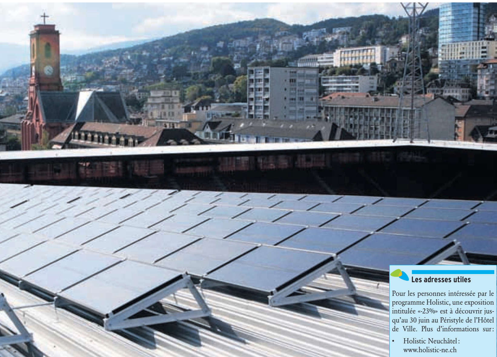
le toit du stade de la Maladière d'ici à 2012.
